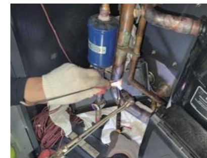
지열히트펌프 압축기 교체
