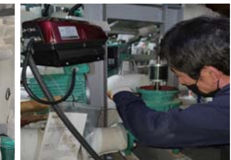
펌프류 소모품 점검 미 교체
