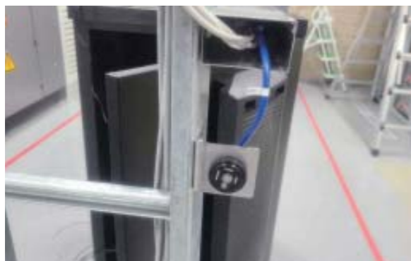
Off 가스 감지 센서 설치
