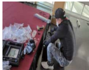
다목적실 음향시스템 공사
